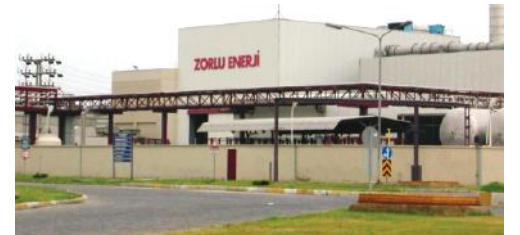
Zorlu Enerji 4 Borulu CV Soğutma Grupları
