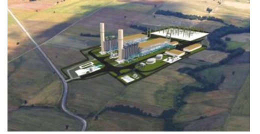
Boufarik Power Plant Tüm HVAC Sistemi
