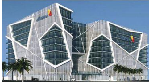
Al Baraka Gn. Md. Cezayir CV Tüm HVAC Sistemi
