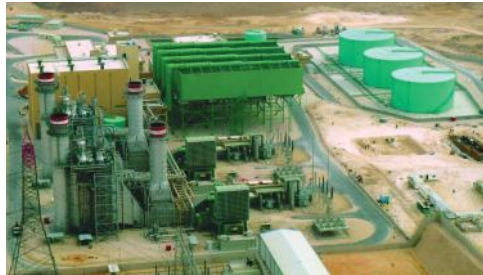
Khabat Power Plant Tüm HVAC Sistemi
