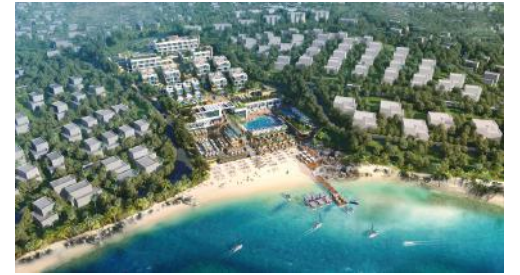
Yalıkavak Otel 6 Borulu CV Soğutma Grupları
